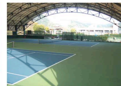
△既設屋根付2面コート
