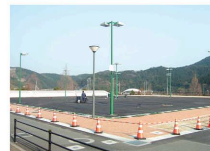
△新設屋外2面コート
