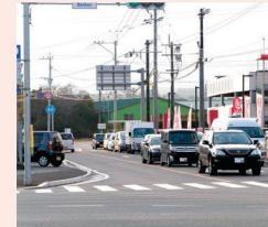
国道200号弁分交差点、椿方面から市内に向かう県道でクラブハウス横の右折帯を15mから65mに延伸し、2017年5月から供用され、特に朝の渋滞が緩和されています
